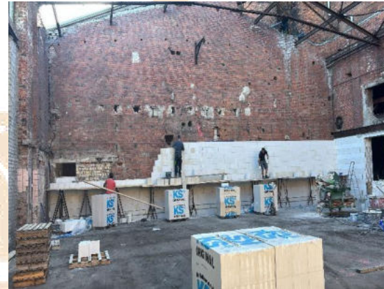
die ersten Wände im Erdgeschoss entstehen
