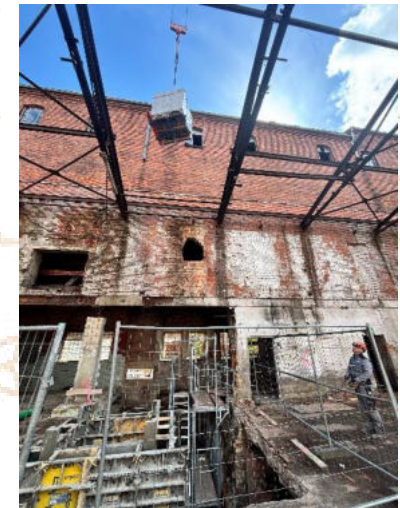
Palettenweise werden die Kalksandsteine mit dem Kran rein gehoben
