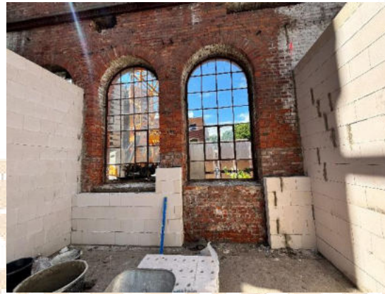
hier entsteht ein Fenster und eine Terrassentür, welche später noch eingeschnitten wird
