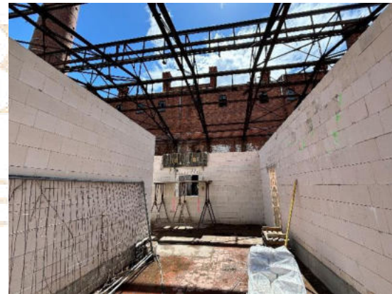
Erdgeschoss - Wände entstehen
