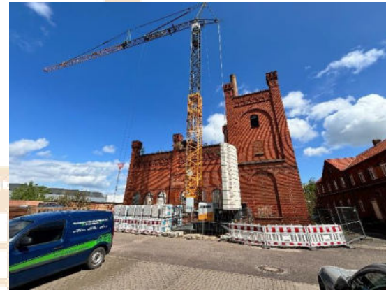
der Kran wurde aufgebaut
