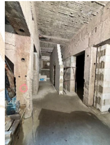
Mauerarbeiten im Keller
