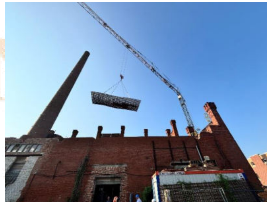
Bewehrung der EG Decke wird hinein gehoben
