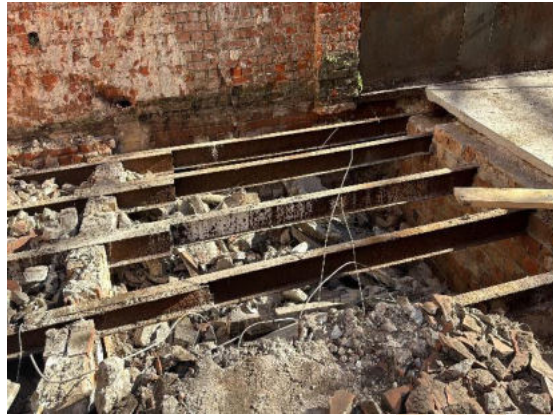
Teilabbruch der EG-Decke über dem Luftkanal
