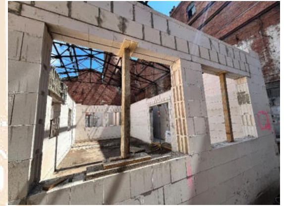
Blick aus dem Flur im Erdgeschoss in das Atrium
