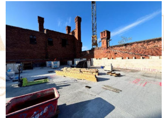
die ersten Wände im 2. Obergeschoss entstehen
