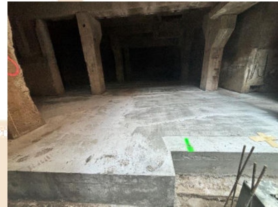
Keller nach Abbruch und Einbringung einer Sauberkeitsschicht
