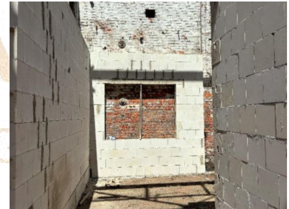
hier sind Schneidarbeiten, um der späteren Küche noch einen Ausblick zu geben
