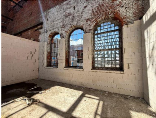
hier entstehen später ein Schlafzimmer und eine Küche
