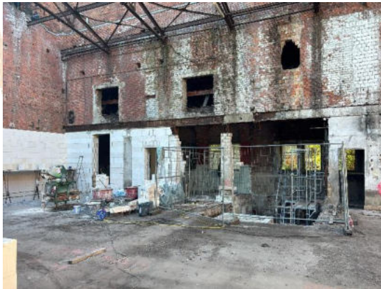
Erdgeschoss - Wände entstehen
