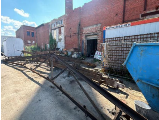
nach Einbringen der Decke im EG hat der Statiker die Entfernung der Stahldachbinder freigegeben
