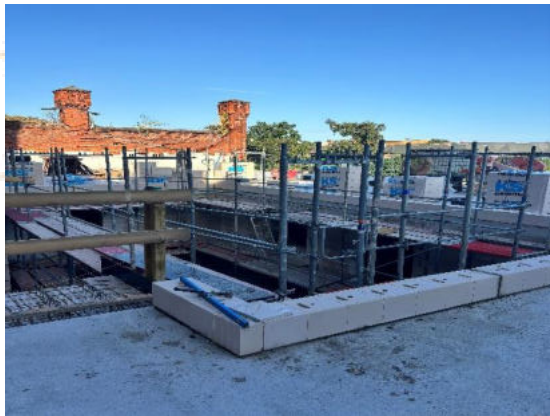
Blick auf das Atrium
