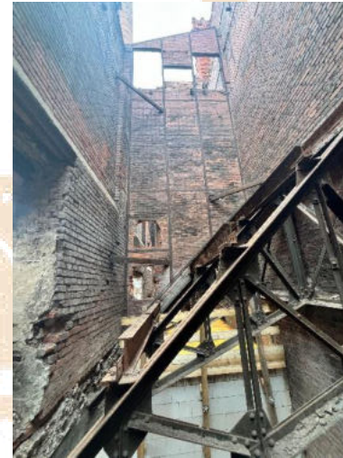
die Trennwand wird auch abgebrochen
