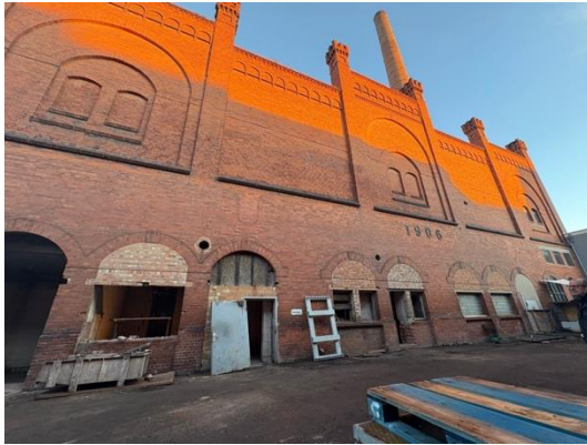
Zustand vor Fensteröffnungen
