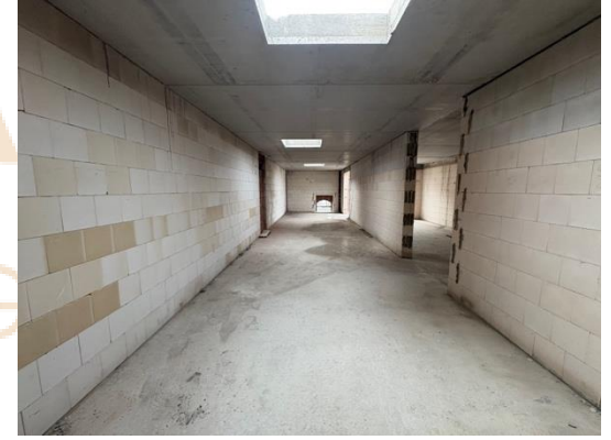
Dachgeschoss mit Oberlichtern
